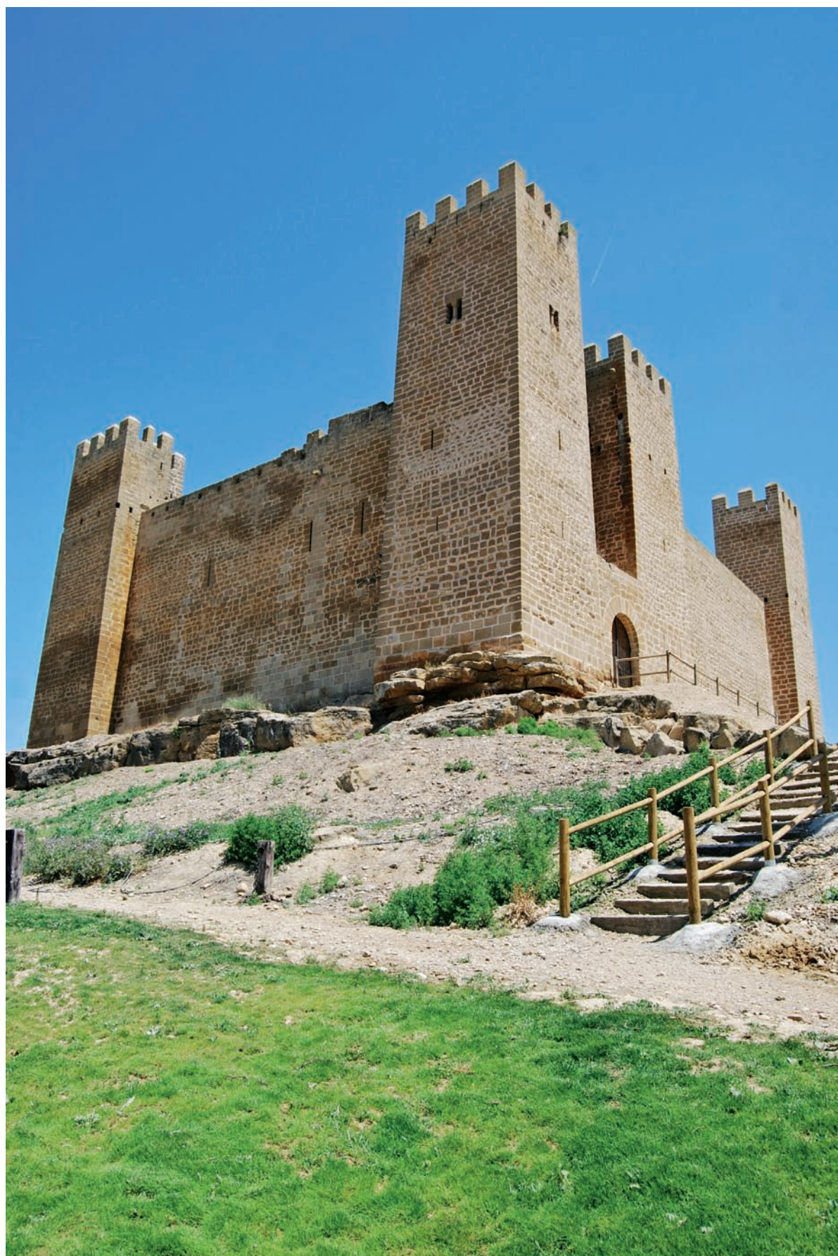
Vista desde el lado suroeste
