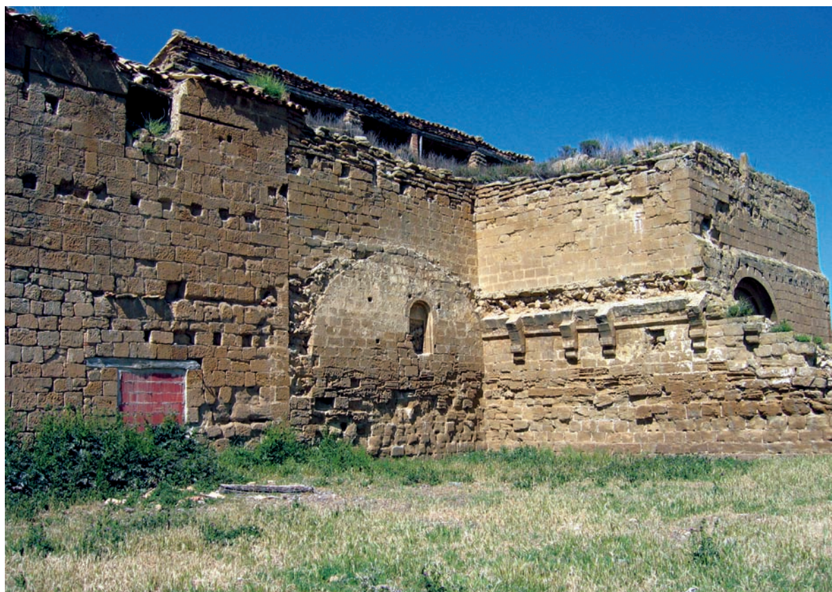
Espacio de la sala capitular
