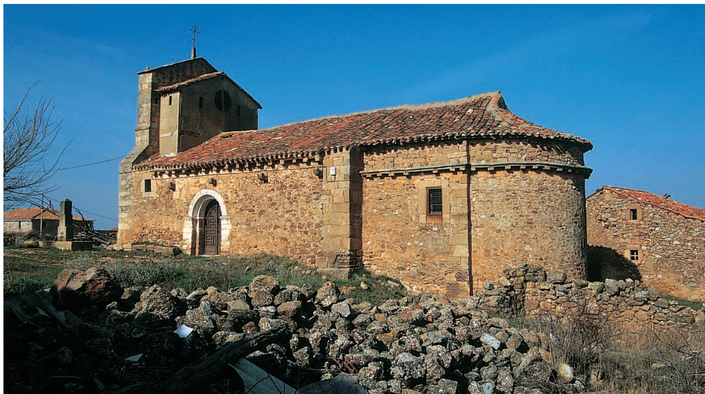
Exterior de la iglesia
