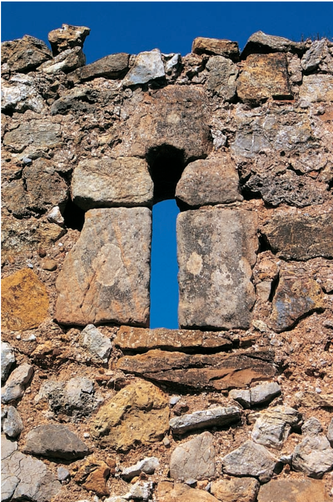
Aspillera del muro sur de la nave
