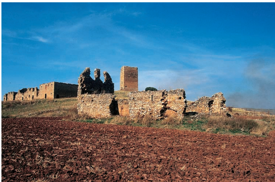
Despoblado de La Pica con la iglesia en primer término
