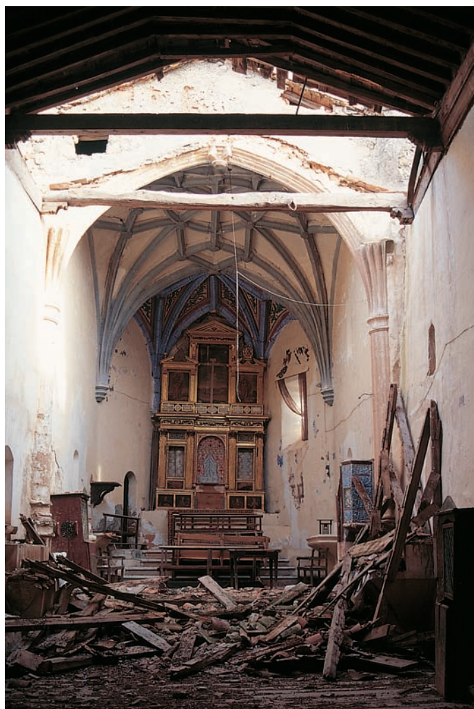
Interior. Estado en 1998
