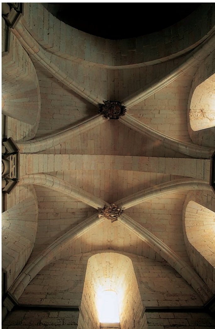
Iglesia. Bóvedas del brazo sur del transepto
