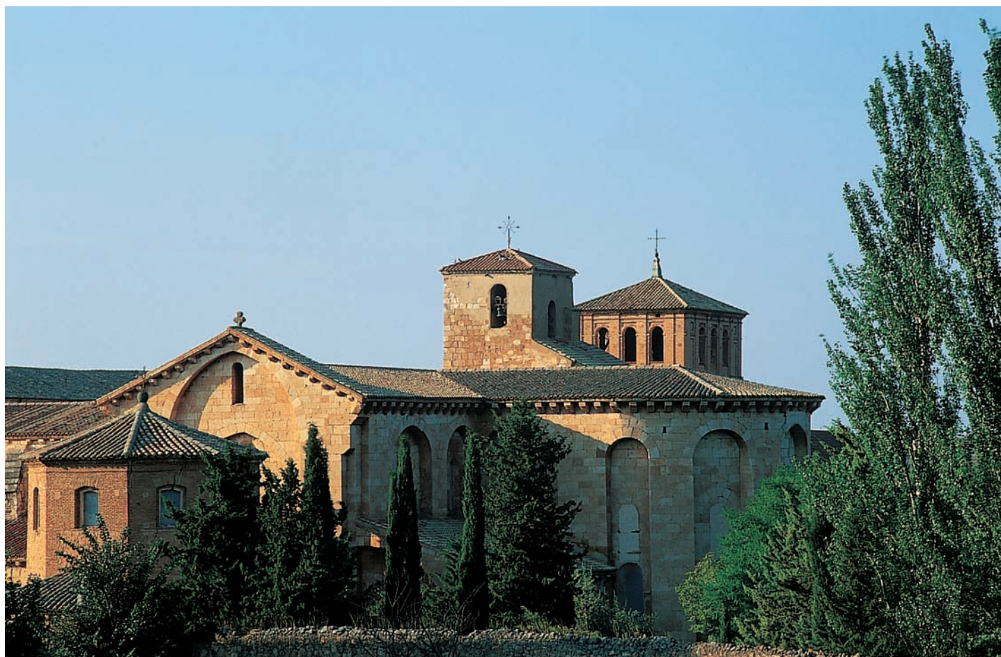
Exterior de la cabecera del templo
