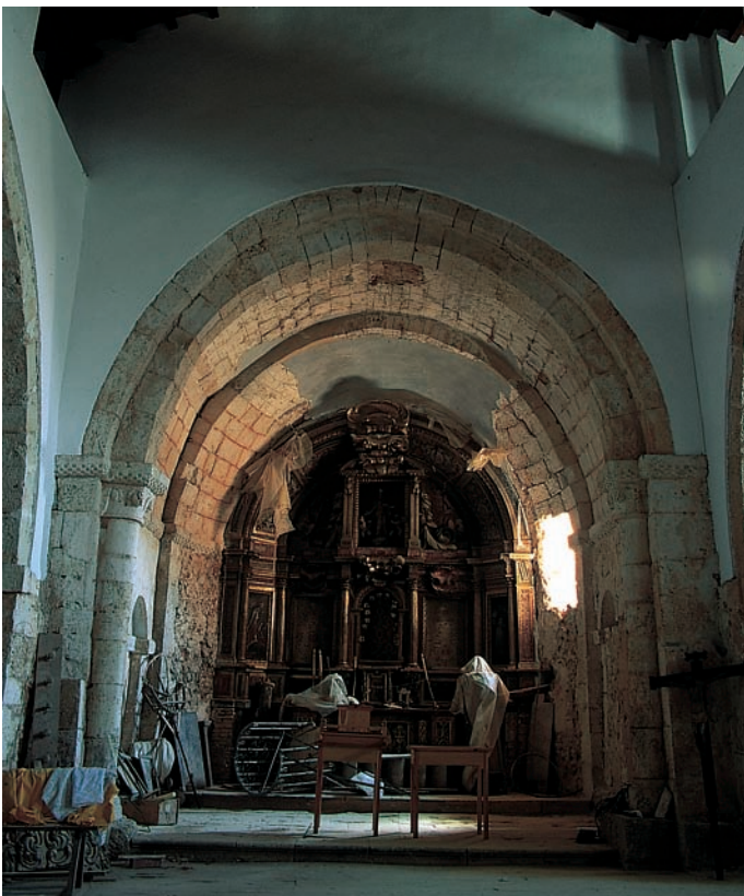
Interior del templo
