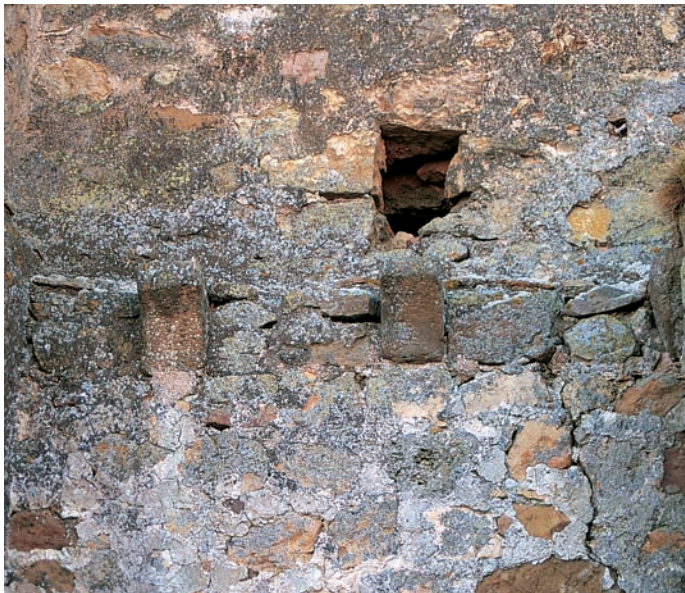
Carabantes. Canecillos del muro norte
