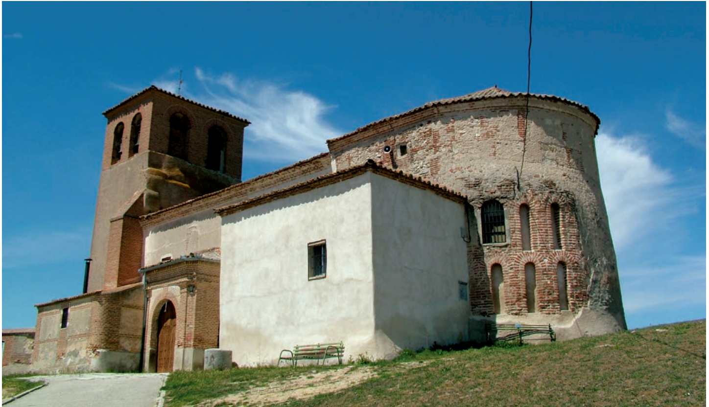
Vista general de la iglesia
