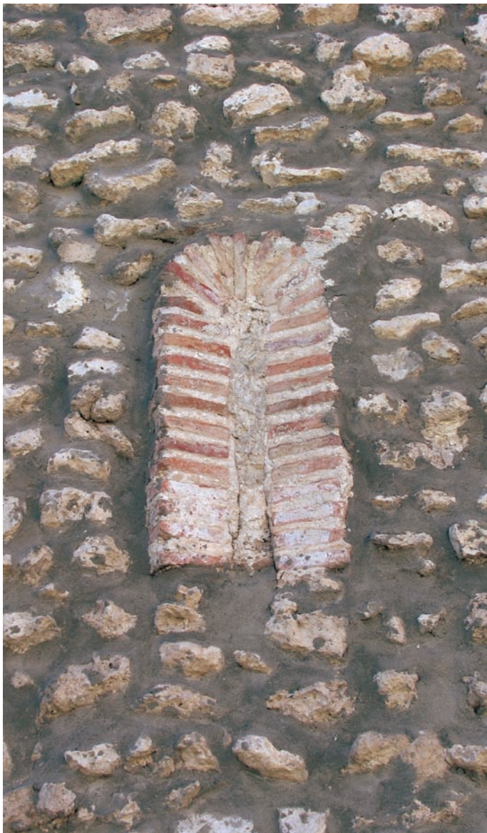
Vano en el ábside
