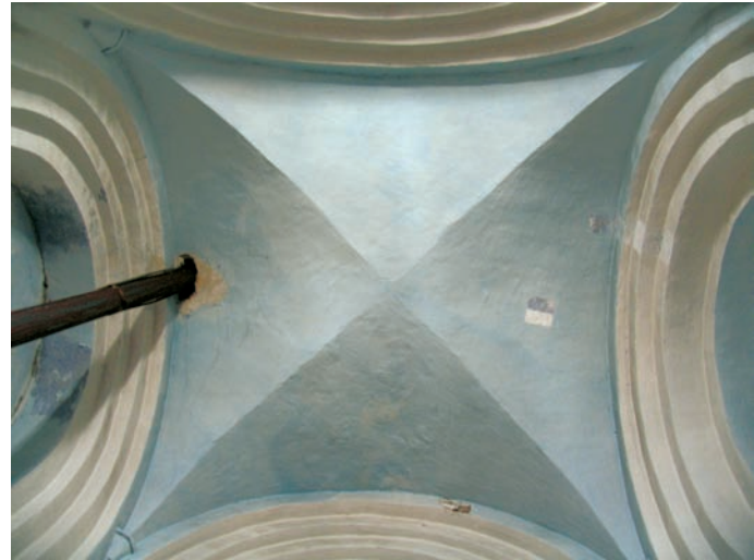
Bóveda de la capilla lateral
