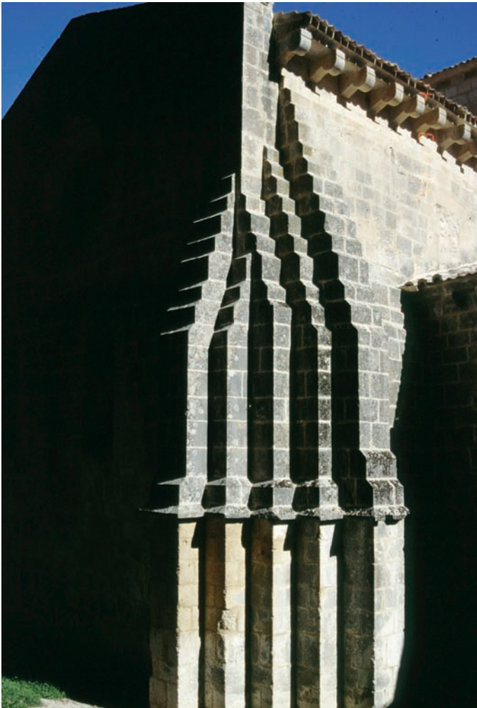
Contrafuertes de la iglesia
