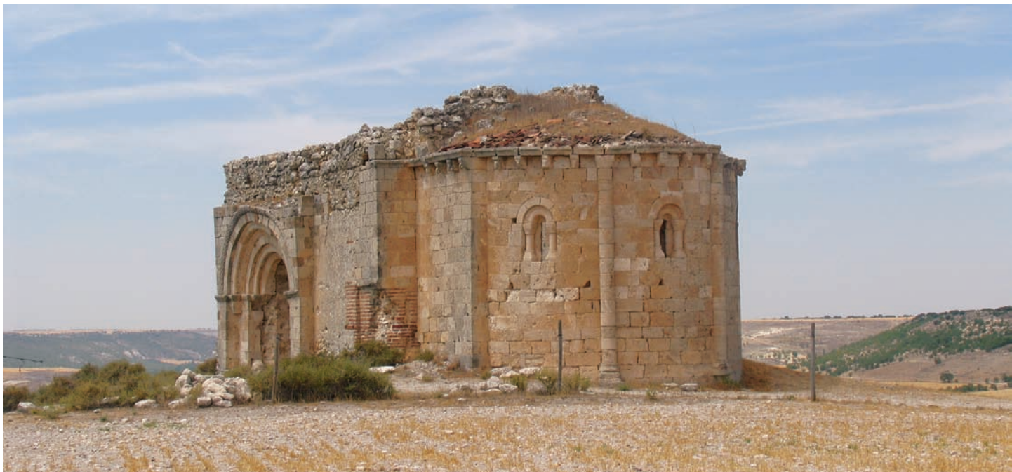
Exterior desde el sureste
