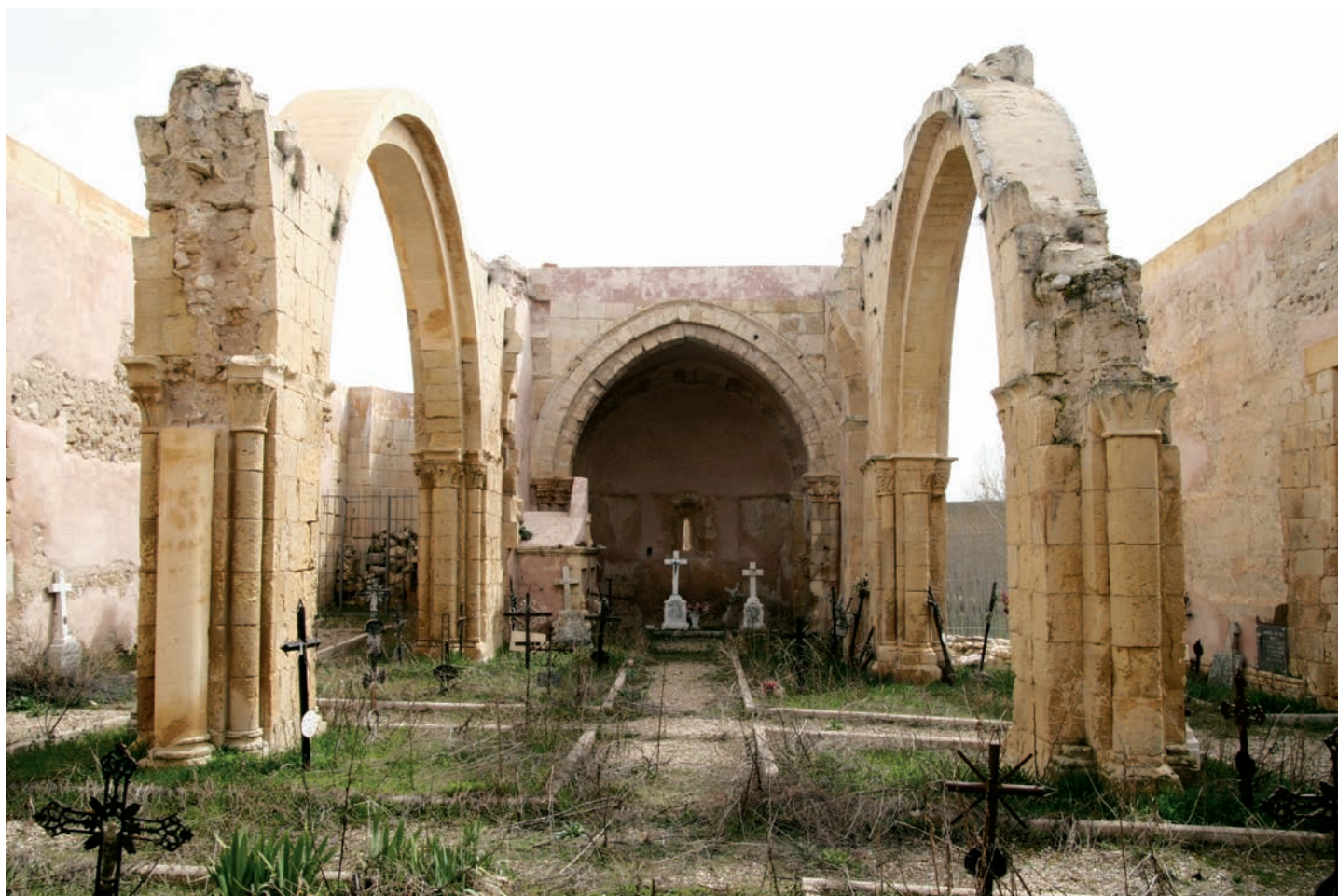
Interior de las naves
