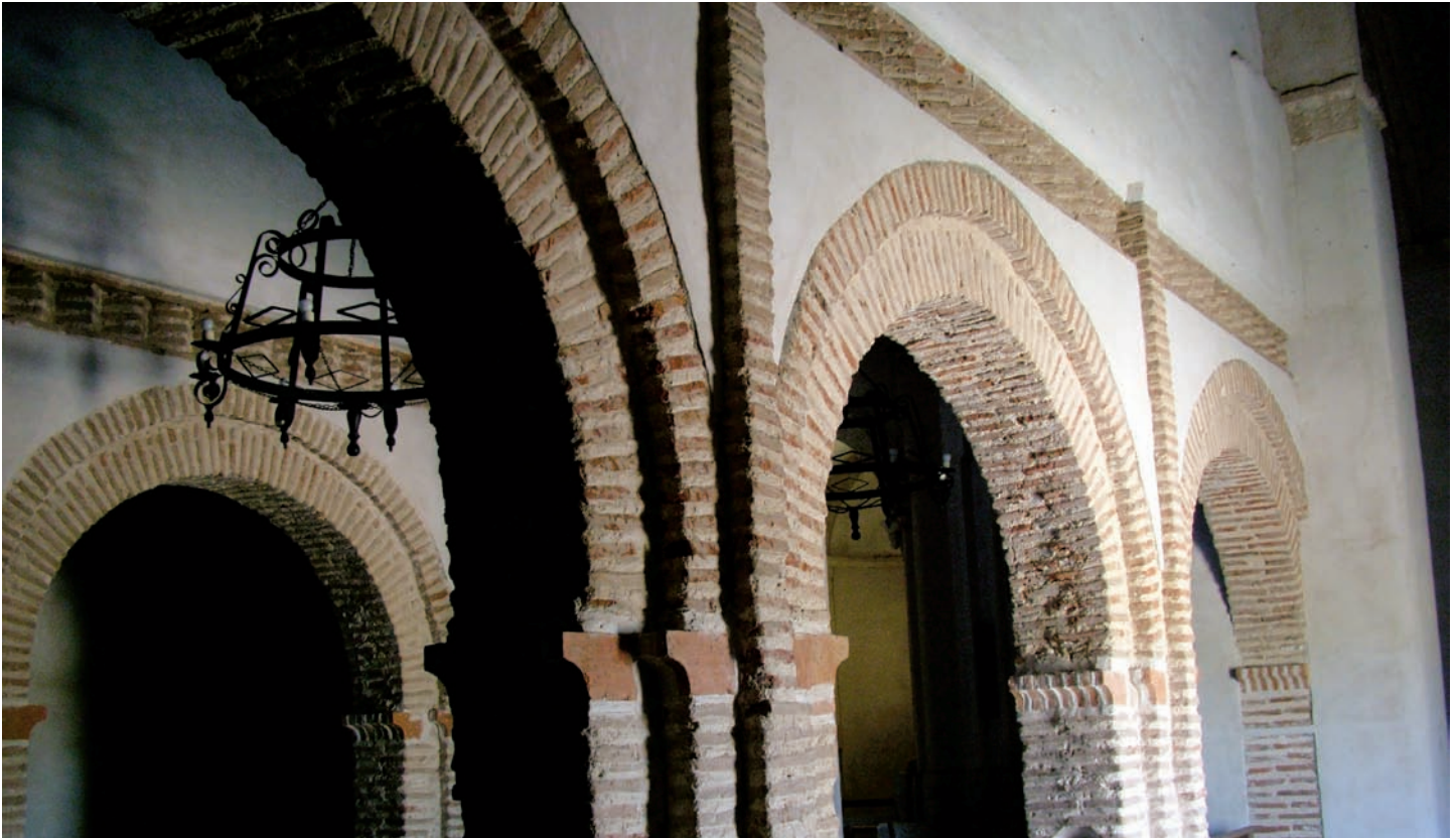
Interior de las naves
