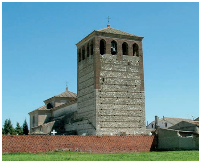
Vista de la torre
