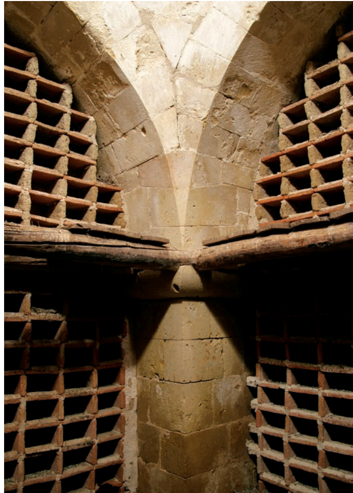
Detalle del despiece de una pechina
