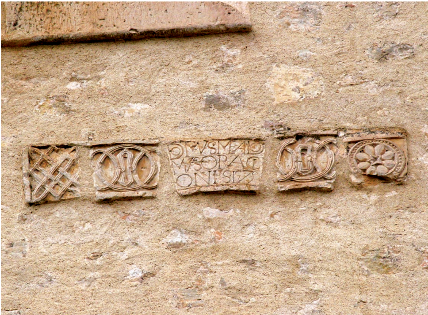
Dovelas empotradas en los muros de la iglesia
