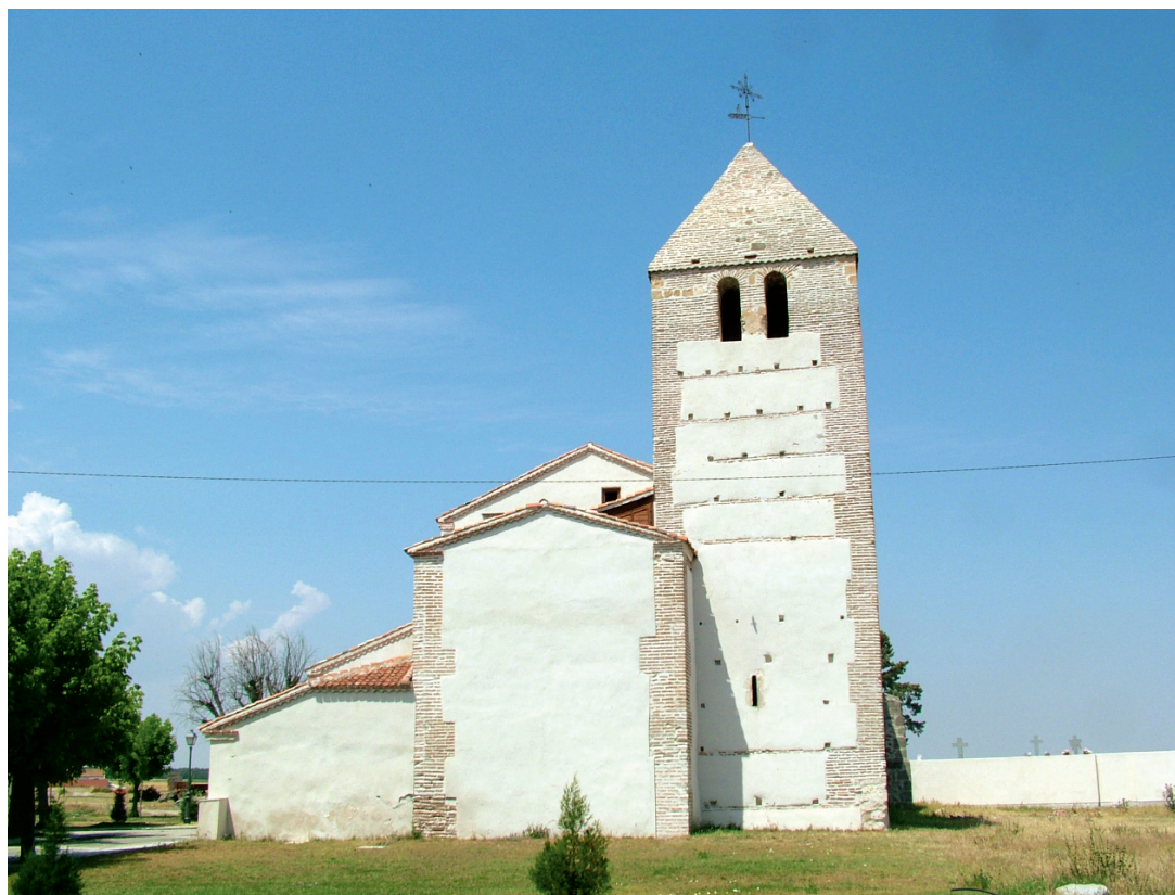
Exterior del ábside y de la torre
