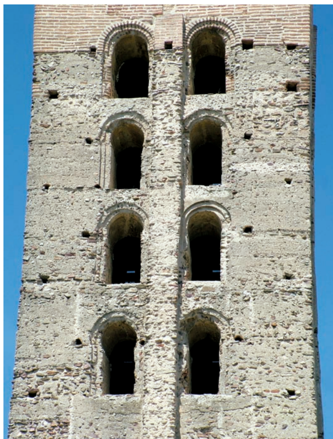
Detalle de los aparejos de la torre
