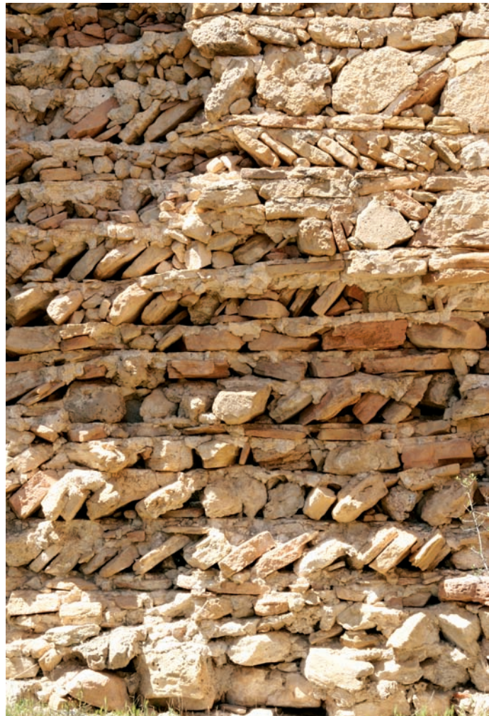
Detalle del aparejo del bastial occidental
