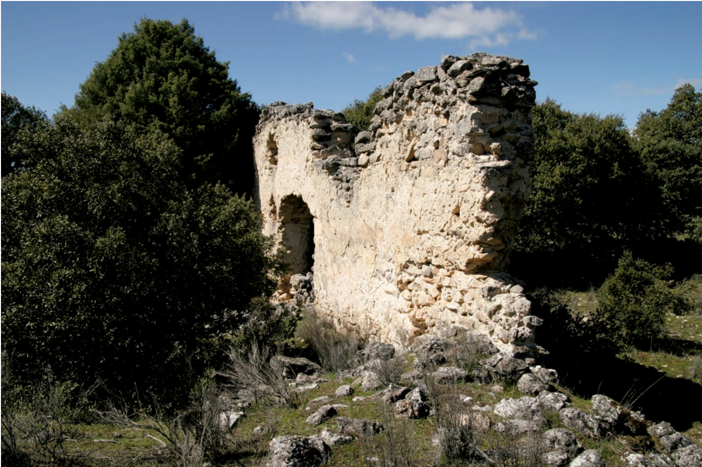
Restos de la nave
