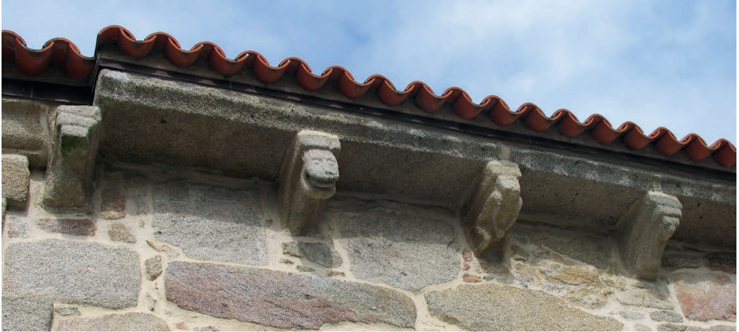
Canecillos del muro sur
