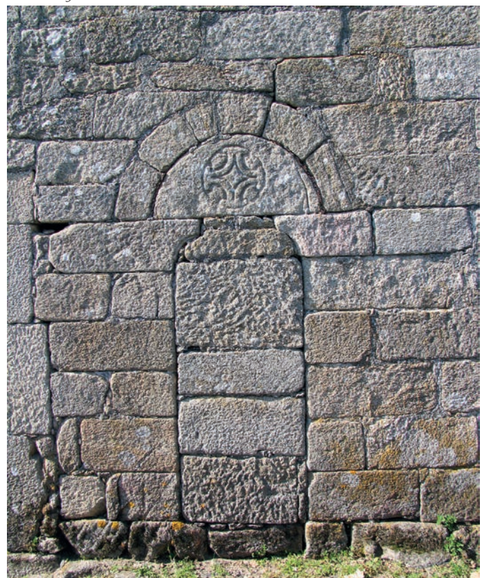
Portada cegada del sur
