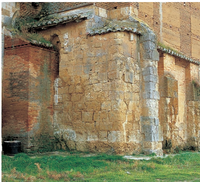
Muro norte del edificio
