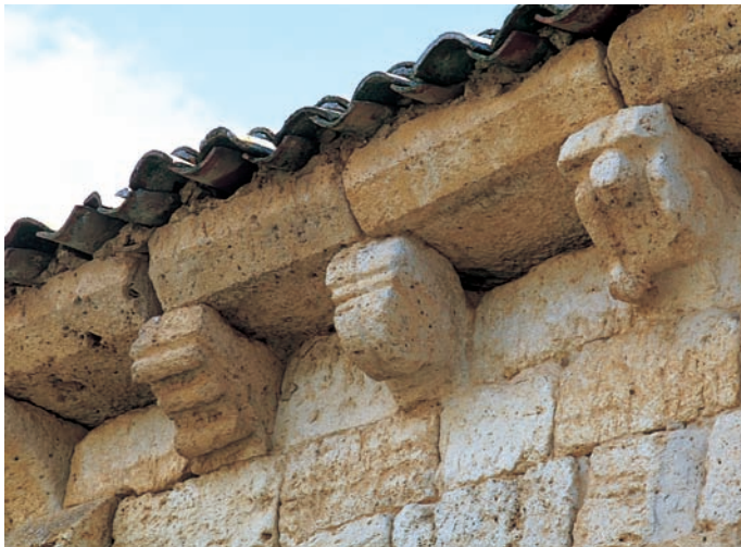
Detalle de la cornisa
