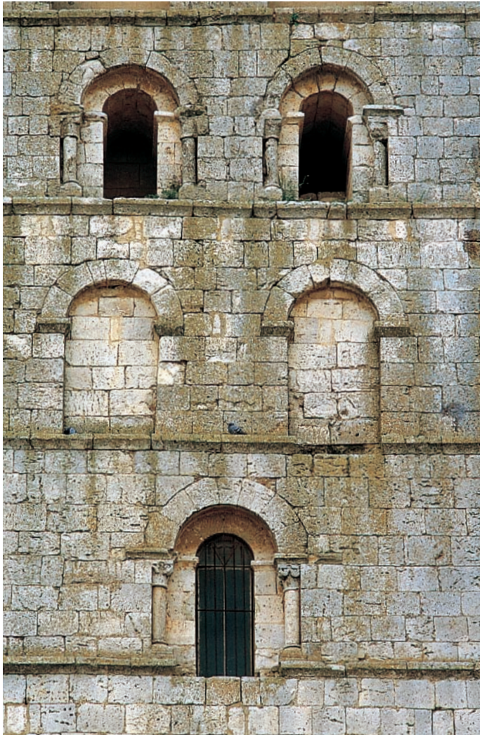
Detalle de la torre
