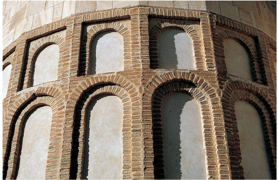
Detalle de las arquerías ciegas del ábside
