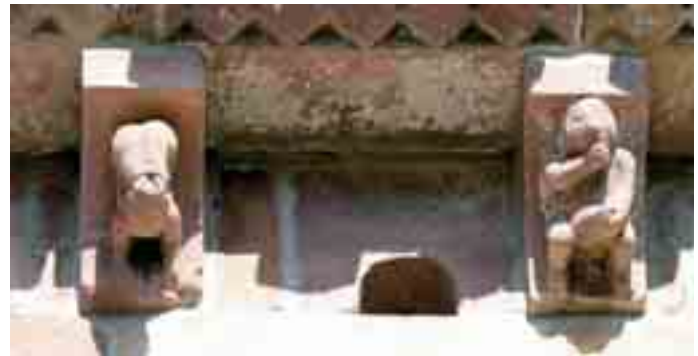
Canecillos 10 y 11 del muro sur
