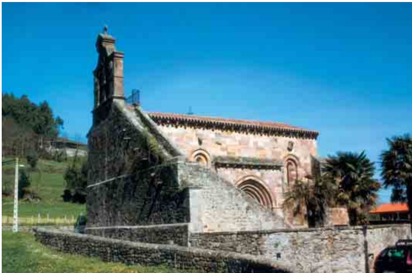
Vista general de la iglesia de Santa María de Yermo
