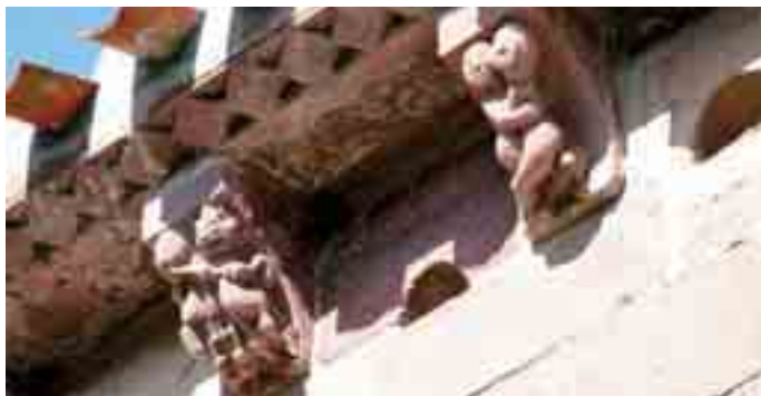
Canecillos 19 y 20 del muro sur
