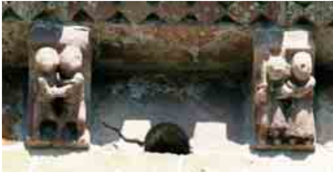
Canecillos 16 y 17 del muro sur
