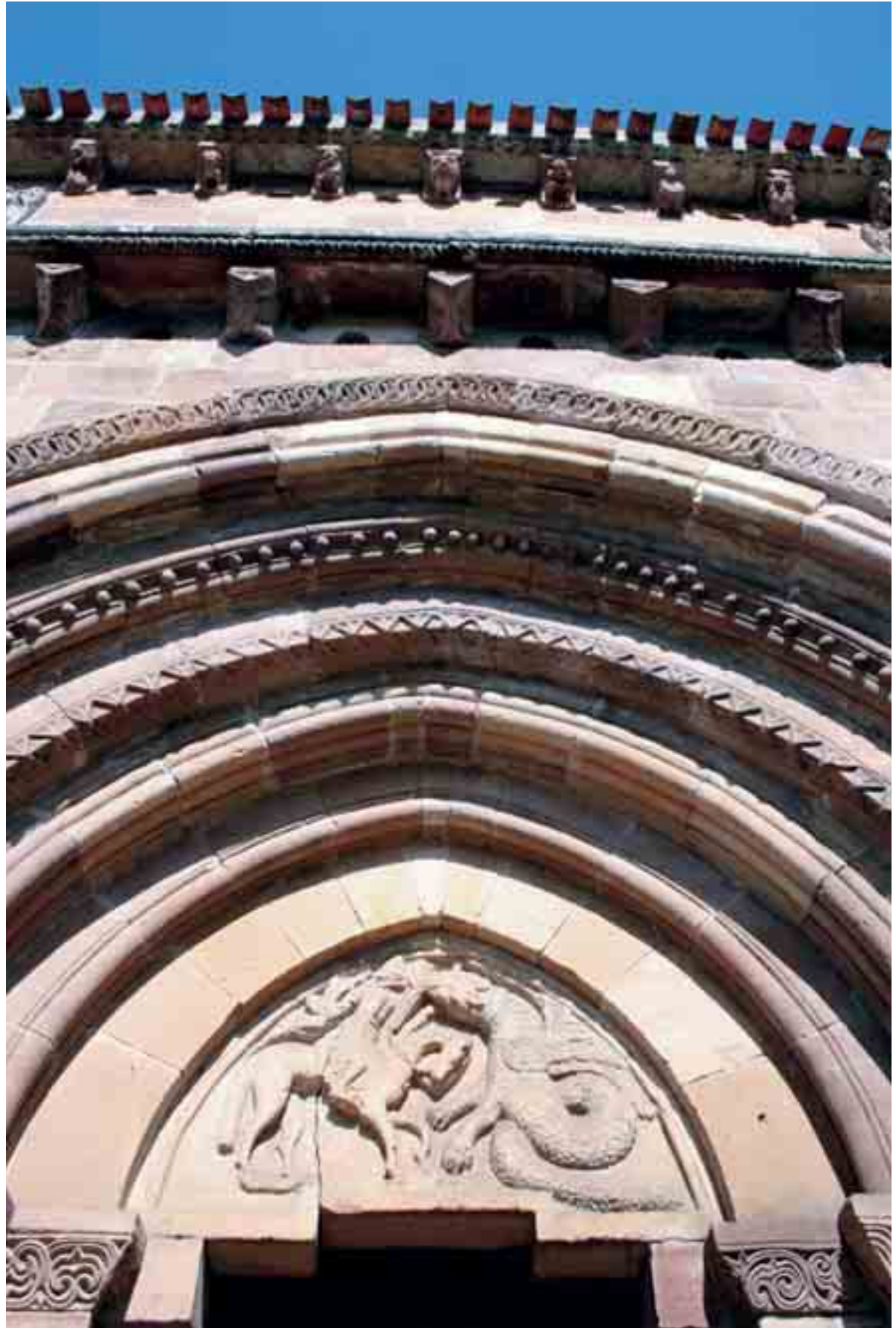
Detalle de la puerta meridional, mostrando arquivoltas, timpano y canecillos de la puerta y de la cornisa
