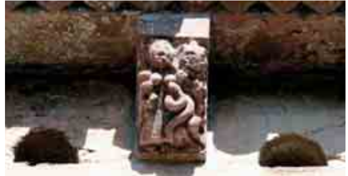
Canecillo 18 del muro sur
