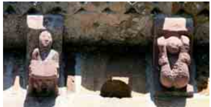
Canecillos 14 y 15 del muro sur
