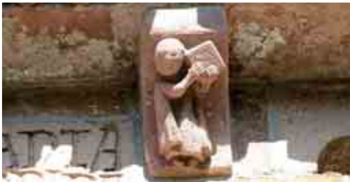
Canecillo 9 del muro sur
