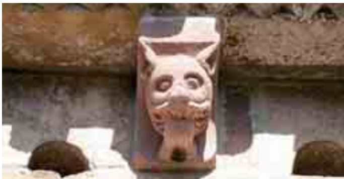
Canecillo 12 del muro sur
