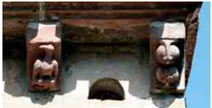
Canecillos 21 y 22 del muro sur
