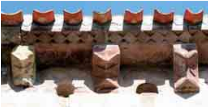
Canecillos 1, 2 y 3 del muro sur
