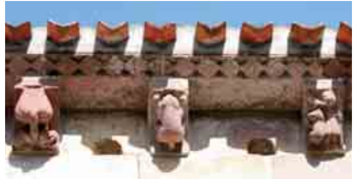
Canecillos 4, 5 y 6 del muro sur
