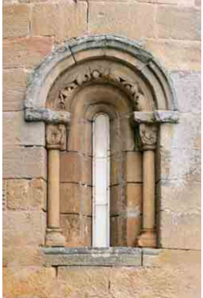
Ventana central del ábside
