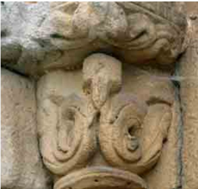
Capitel izquierdo de la ventana central del ábside
