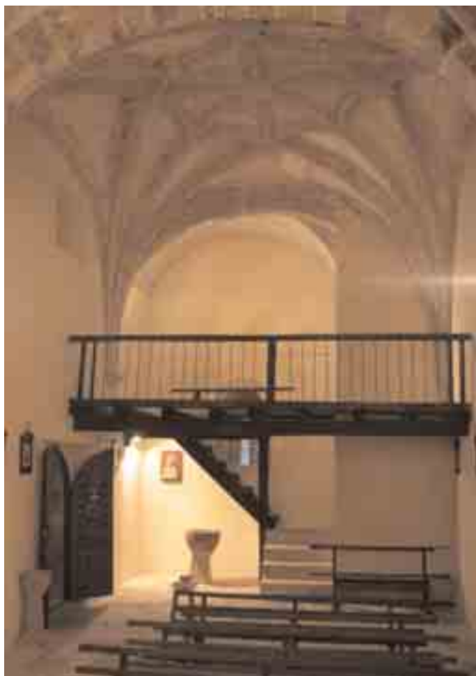
Interior. Vista de la cubierta gótica de la nave y al fondo pila bautismal románica
