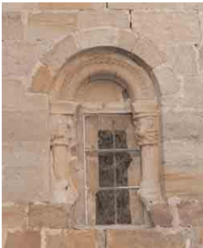
Ventana del muro sur del ábside
