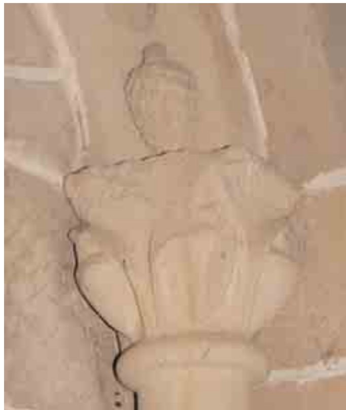
Ventana interior del ábside. Capitel derecho
