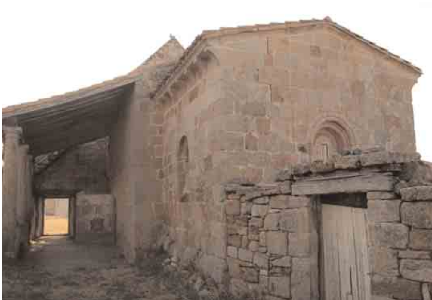
Pórtico de la iglesia y cabecera absidal
