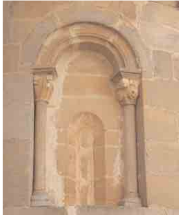
Ventana de la calle central del ábside. Exterior
