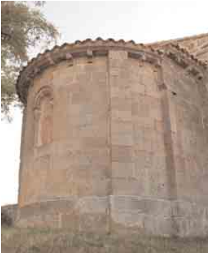
Detalle del ábside (lateral derecho) y presbiterio norte
