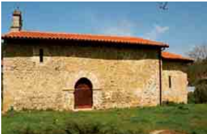
Vista de la fachada meridional
