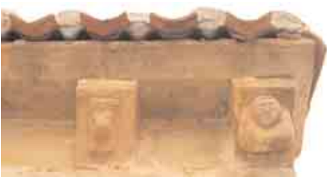
Canecillos 9 y 10 del muro sur de la nave
