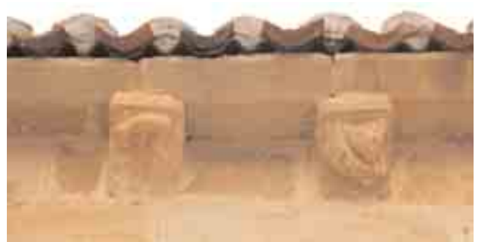
Canecillos 6 y 7 del muro sur de la nave
