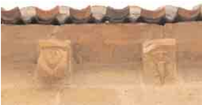
Canecillos 3 y 4 del muro sur de la nave
