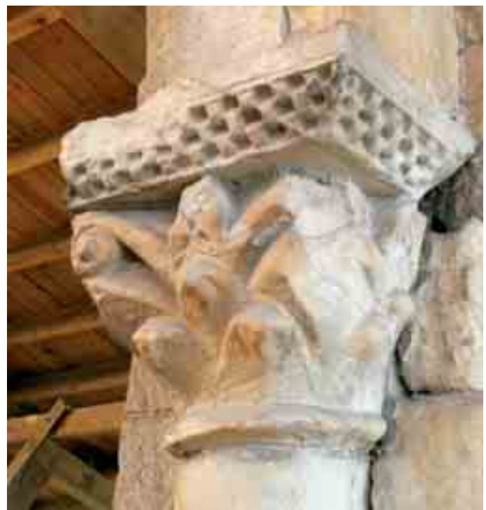
Dos vistas del capitel izquierdo del ábside
