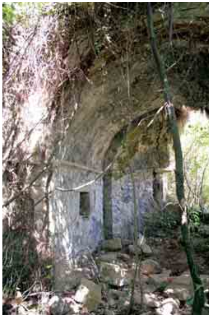
Interior, ábside y nave
