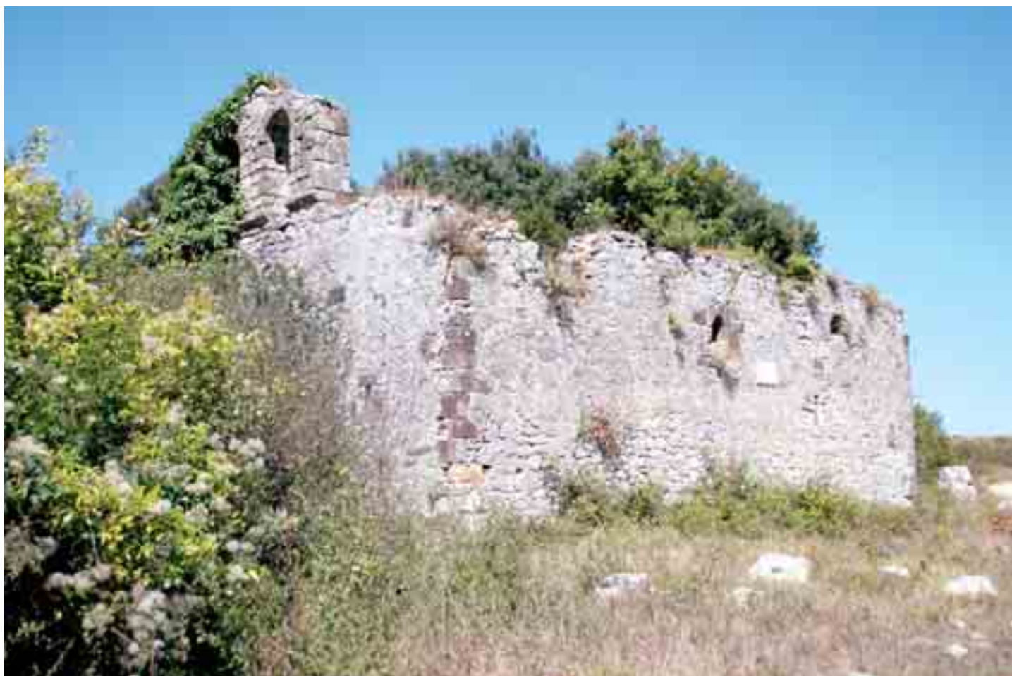
Vista general de las ruinas de la vieja ermita
