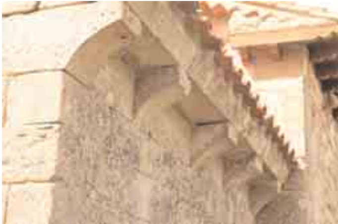
Canecillos del muro norte, del ábside
