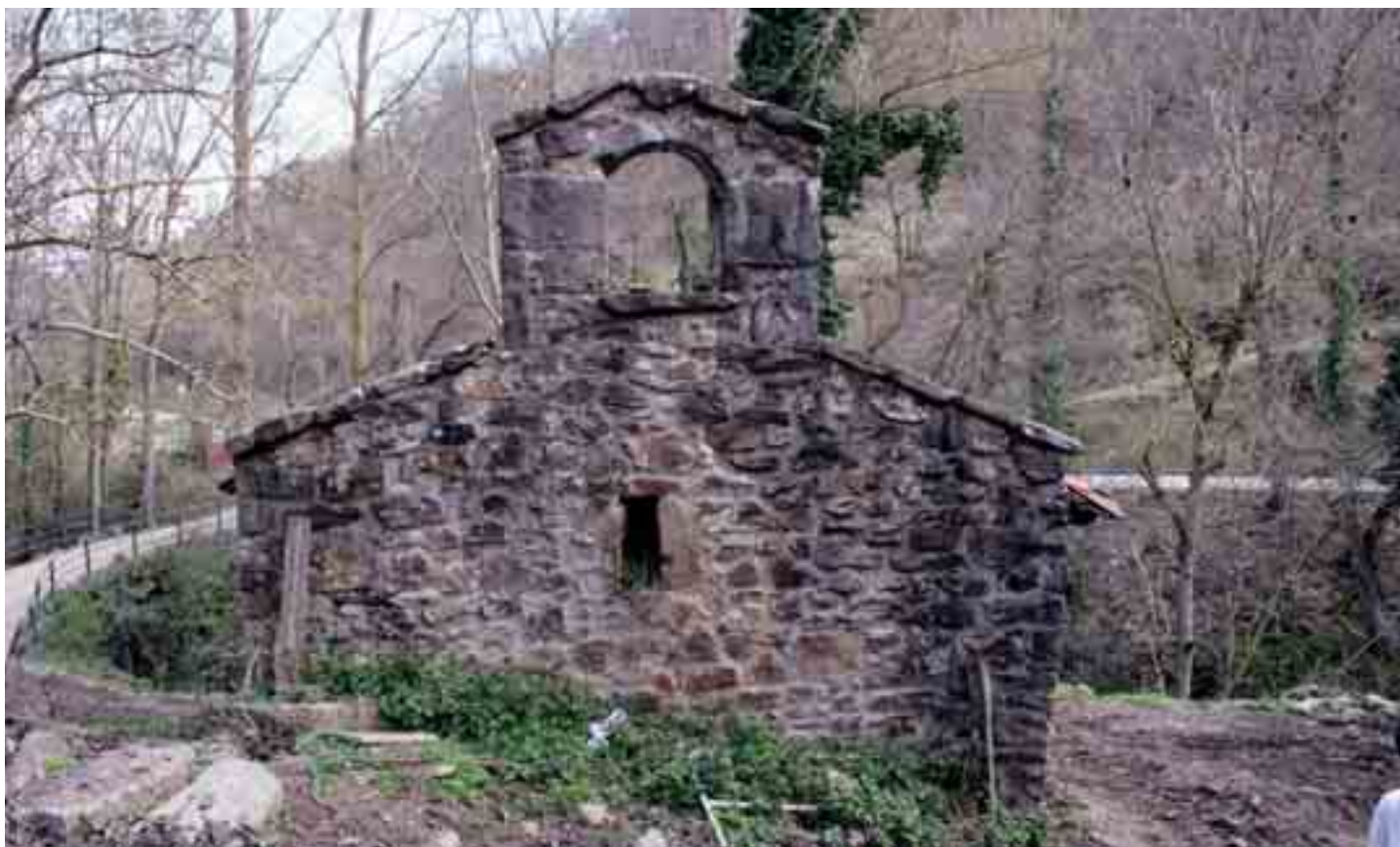
Espadaña y muro occidental de la ermita de Enterría
