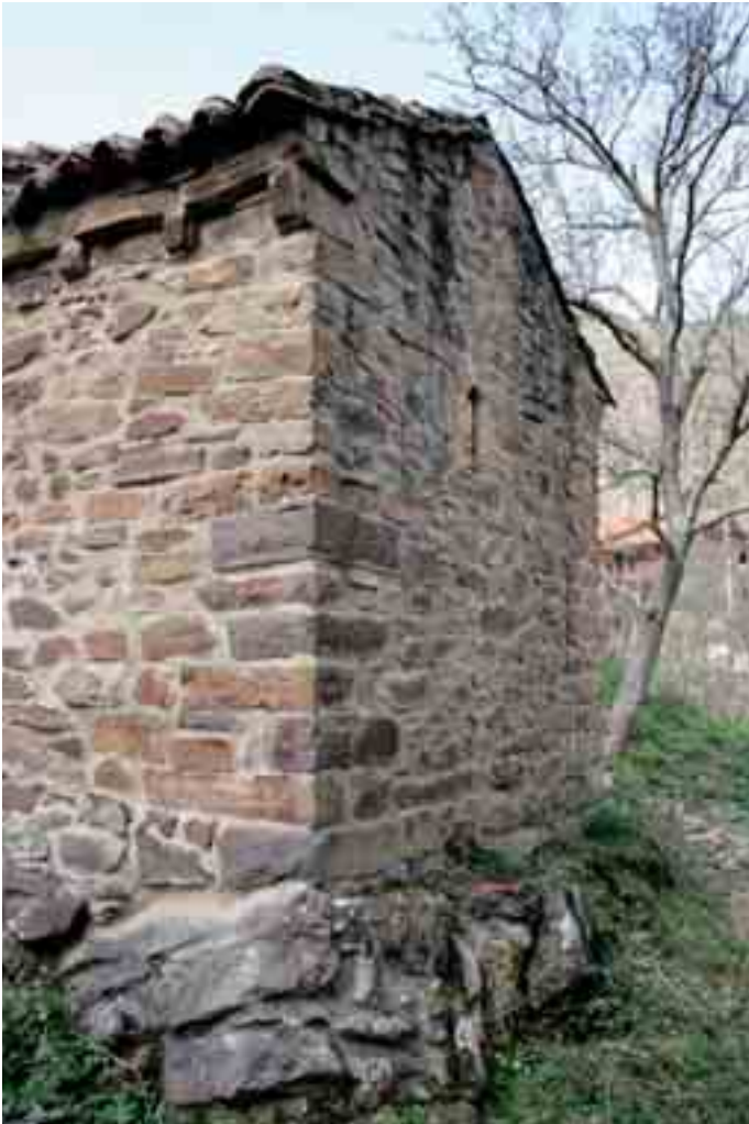
Cabecera (muros meridional y oriental)
