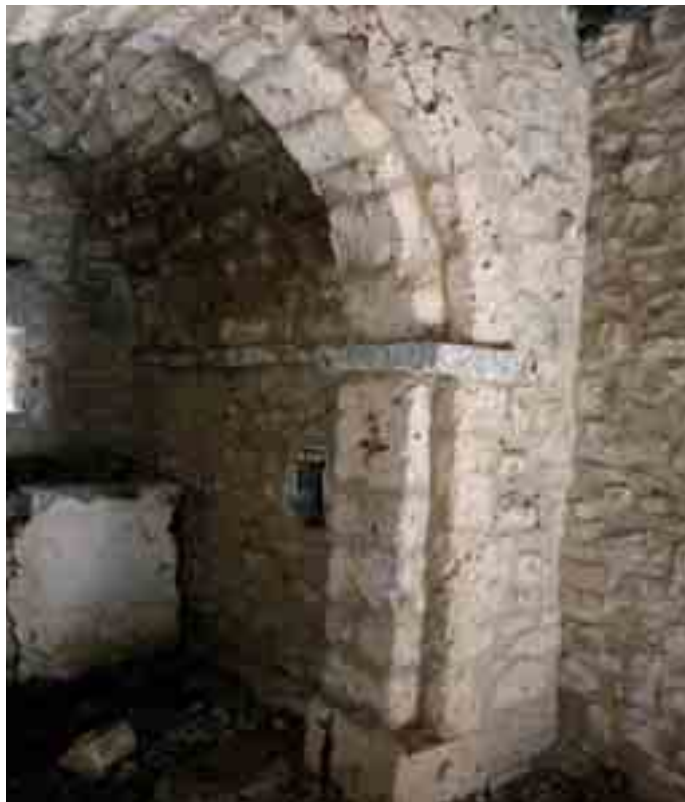
Arco triunfal, lateral derecho. Cimacio de losa
