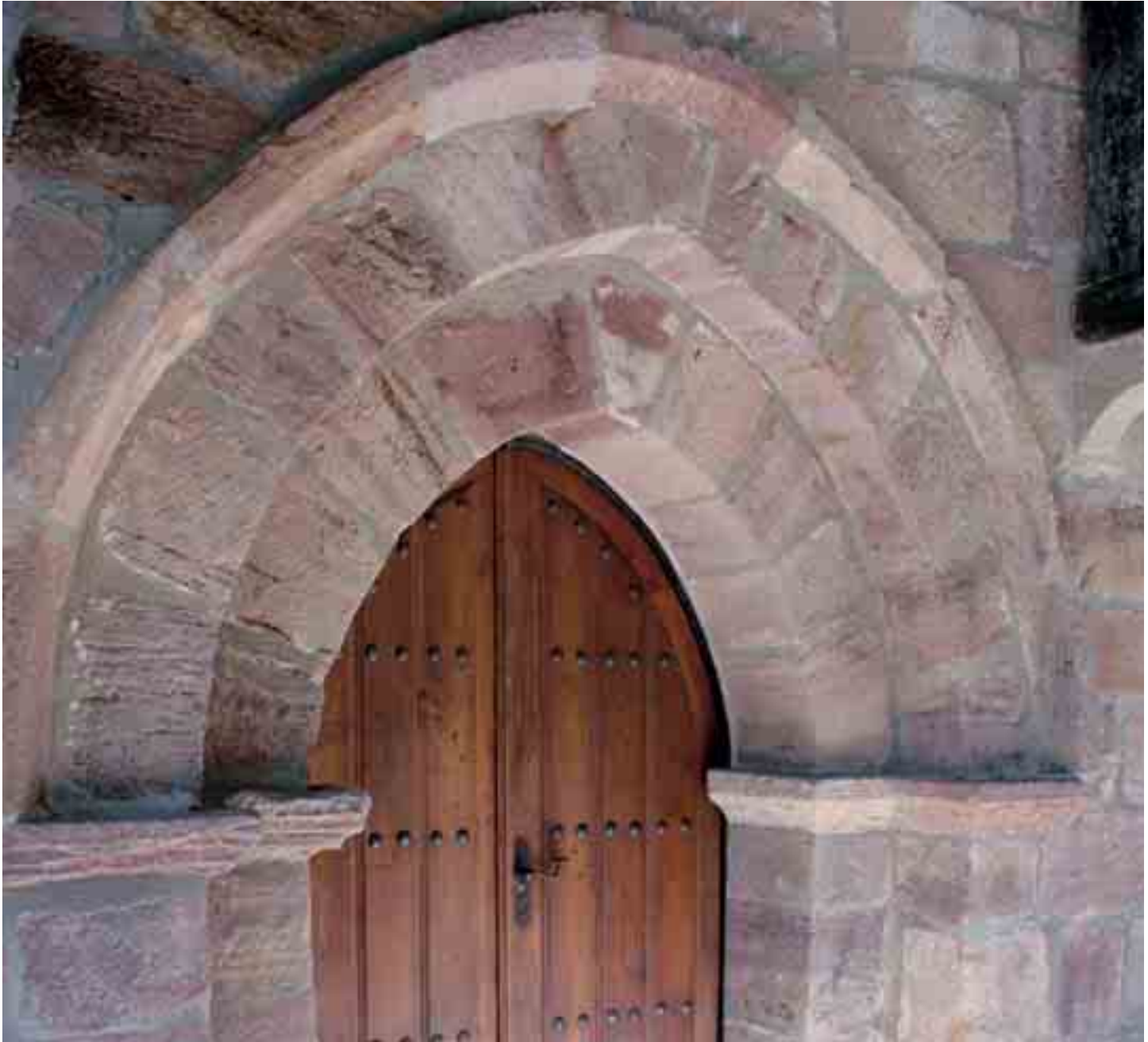
Puerta del muro sur
