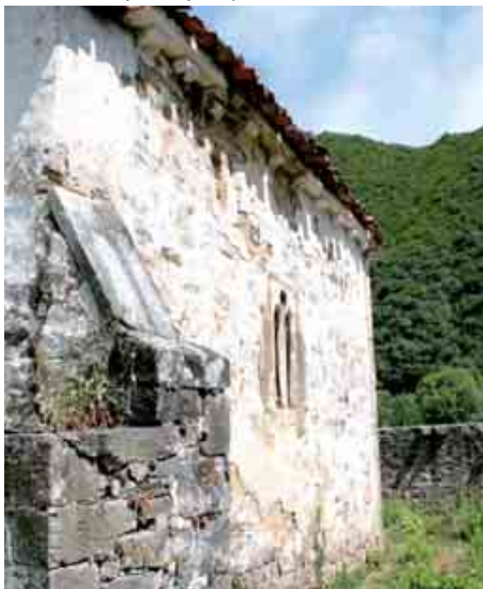
Muro con canecillos, y ventana gótica ajimezada
