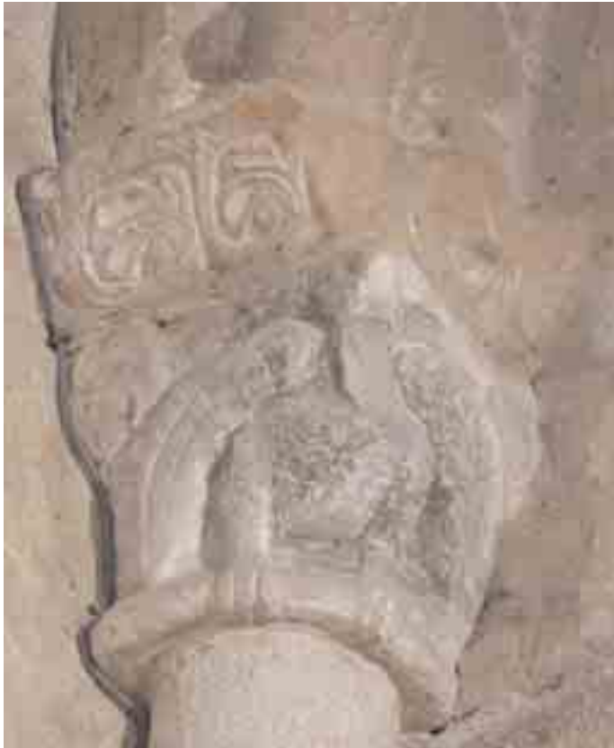
Capitel izquierdo de la ventana interior del muro sur. Destapado en 1969
