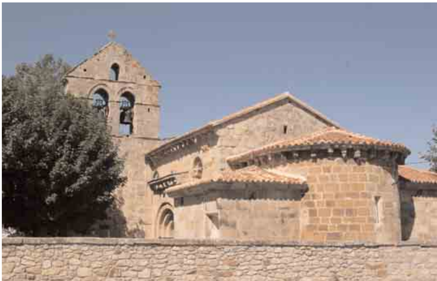
Vista de la iglesia desde el SE
