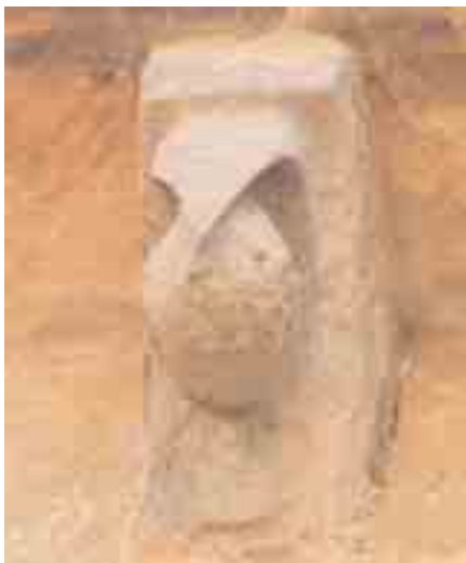
Canecillo 4 del muro norte
