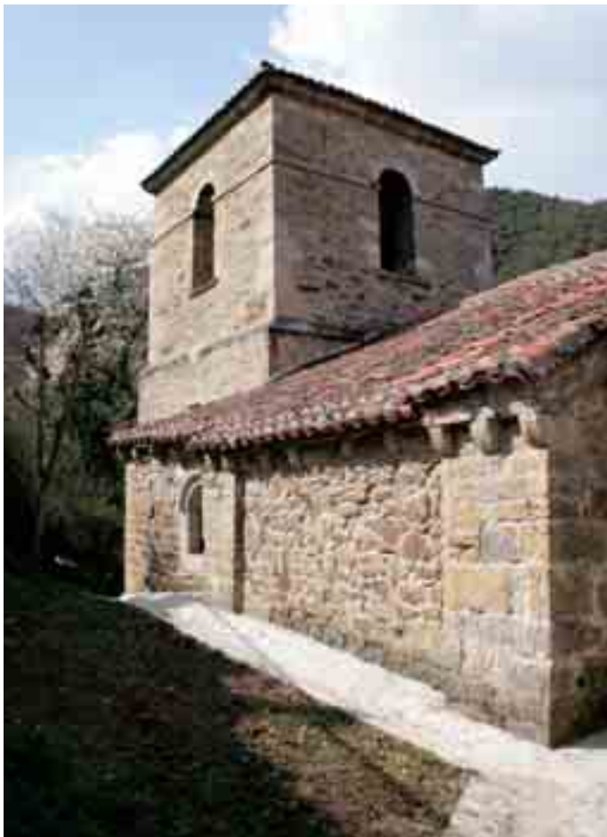
Torre y muro meridional de la nave vieja
