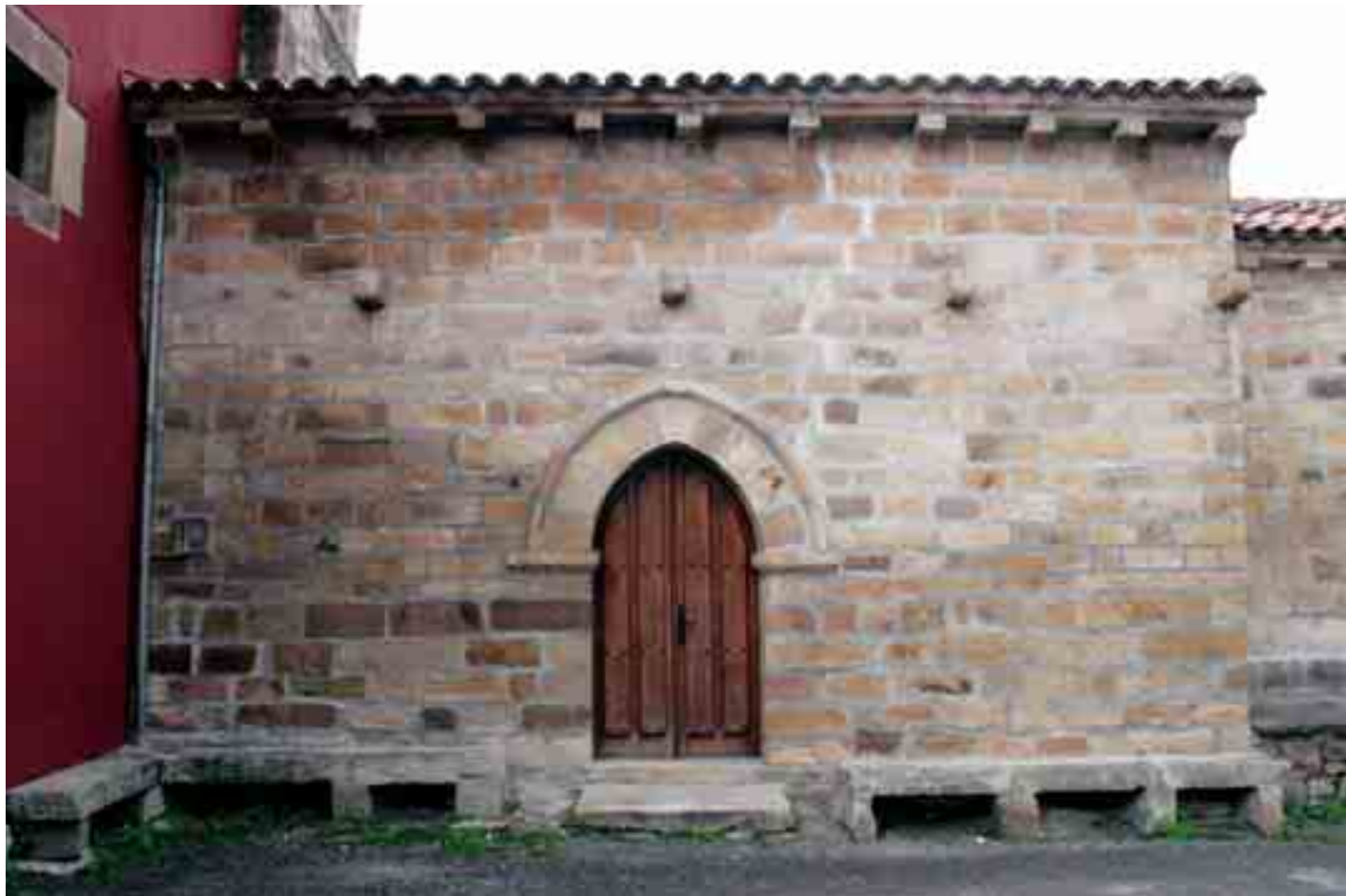
Muro de poniente adosado a la casona, puerta de arco apuntado y canecillos de caveto
