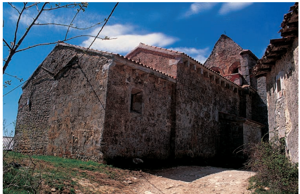
Vista del edificio desde el lado noreste
