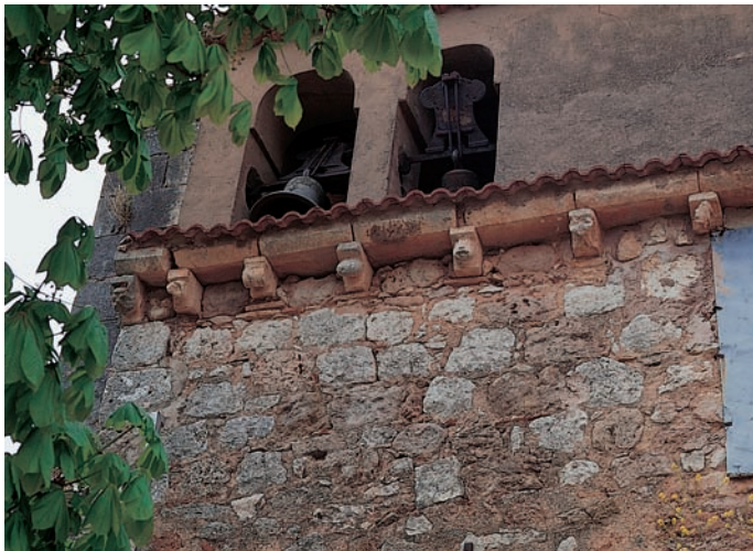
Canecillos del muro sur de la nave
