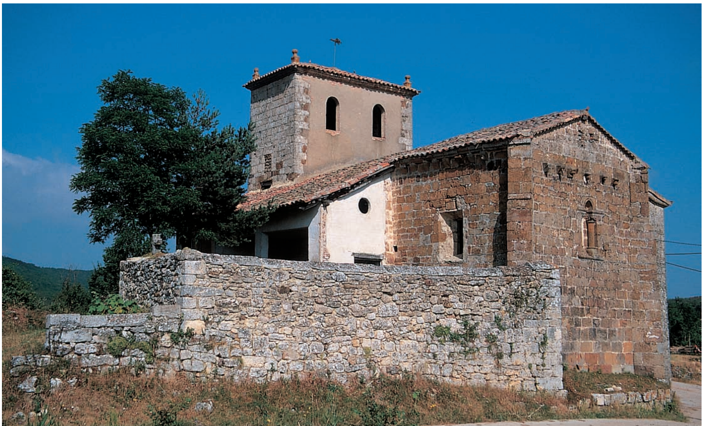
Vista general de la iglesia
