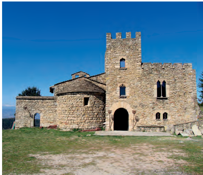
Vista general del conjunto
