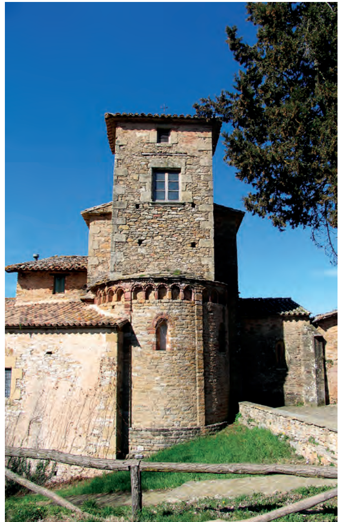
Vista general de la cabecera
