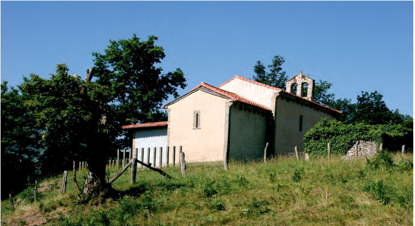
Vista general de la iglesia
