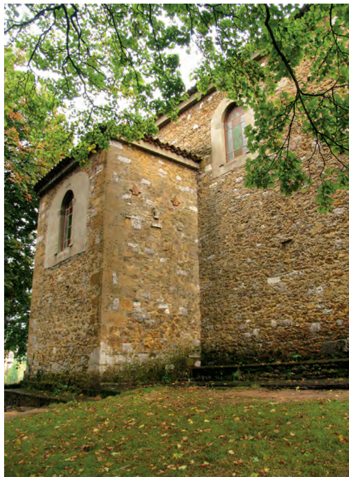
Exterior desde el lado norte
