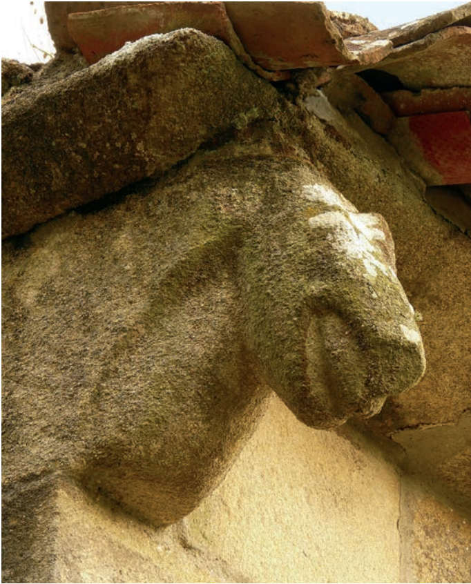
Canecillos del alero sur del ábside
