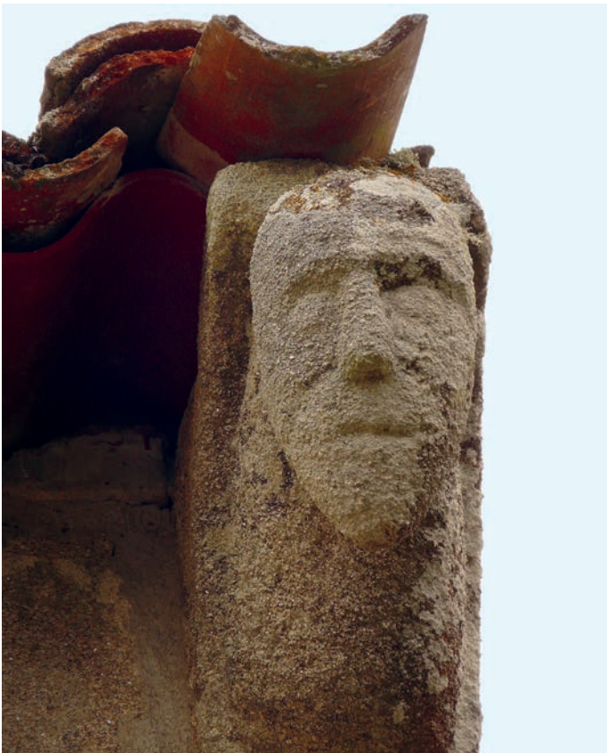
Canecillos del alero sur de la nave
