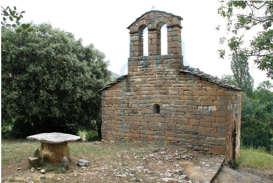
Vista exterior desde el oeste
