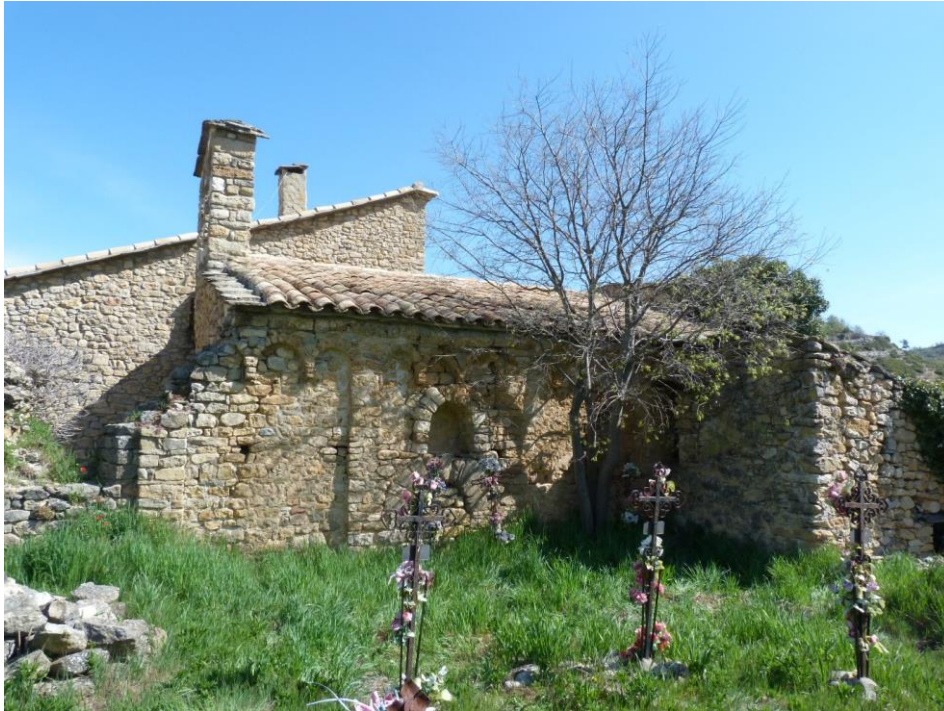
Vista exterior del muro sur
