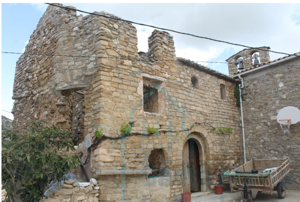
Vista exterior desde el suroeste
