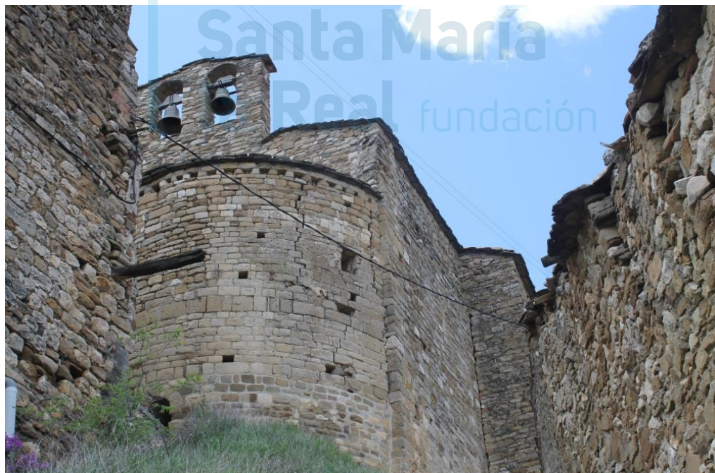
Vista exterior de la cabecera
