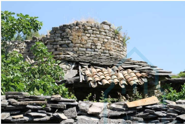
Vista de la torre
