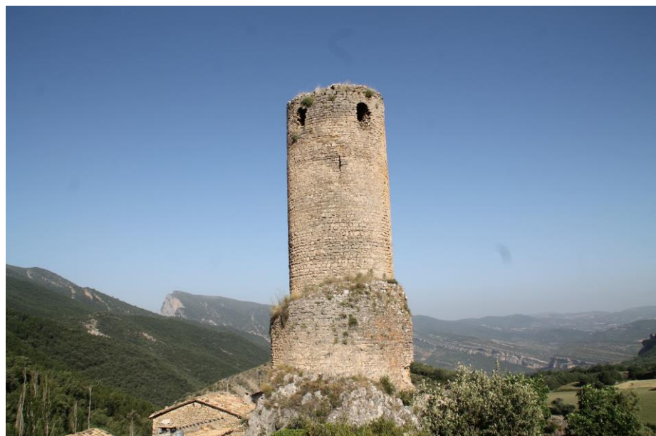
Vista general de la torre
