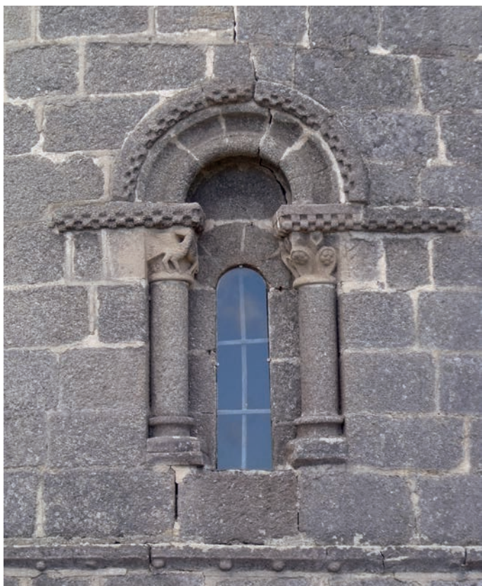
Ventana norte del ábside
