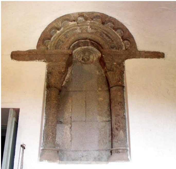
Ventana del muro norte
